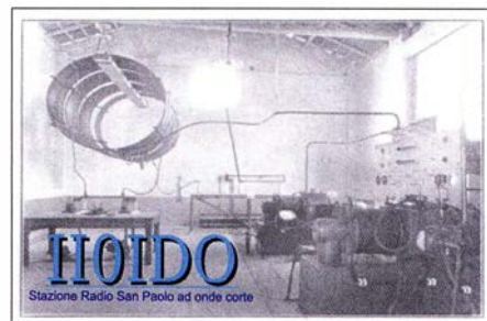
Teil der Sendeanlage von Radio San Paolo QSL: II01DO
