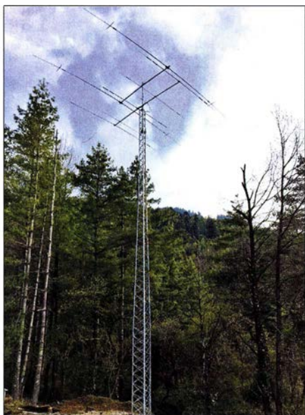
Der neue 20 m hohe Tower
