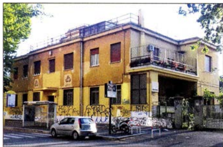
Gebäude des früheren Radio Sao Paolo bei Rom Foto: Sergio S'Afflitto, CC BY SA 4.0
