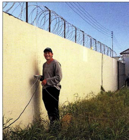
Adrian, KO8SCA, installiert hier die Radials unserer Vertikalantenne für das 80-m-Band.
